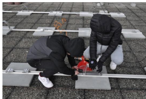
Montage de la structure porteuse
